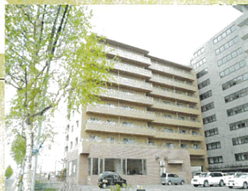
外観 左:パークヒル厚別Ⅱアドニス(全戸西向) 右:パークヒル厚別(一般向け賃貸住宅)
